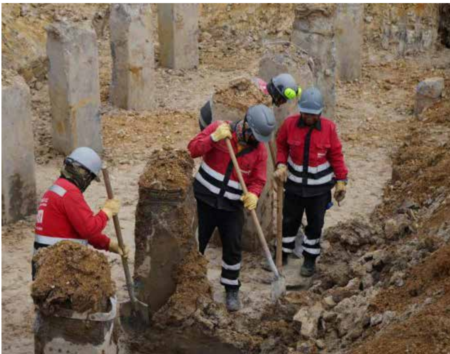
Avance de obra en intersección de la av. NQS con av. Bosa, que mejorará la entrada y salida por el sur de Bogotá.
